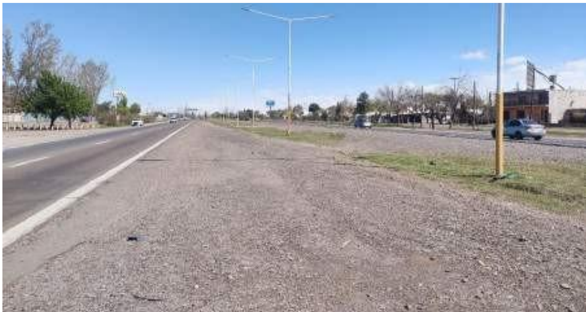
Imagen 5 Separación de calzadas mediante cantero central con sistema de iluminación. Fuente: Elaboración propia. Año: 2025.
