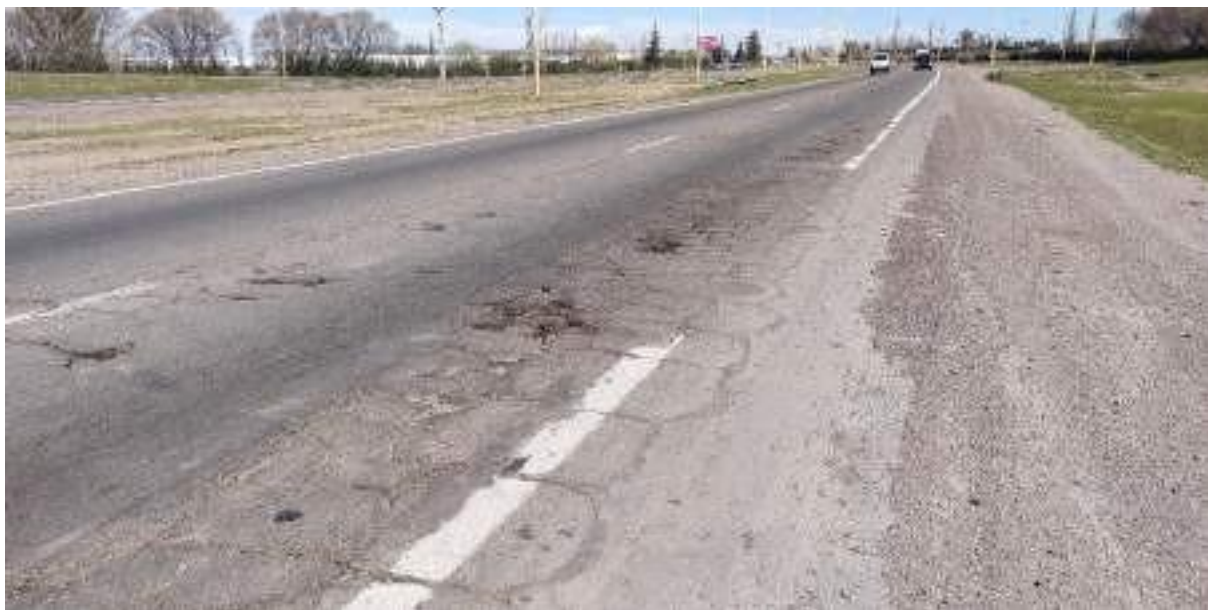
Imagen 3 Estado del pavimento existente y banquina en calzada descendente. Fuente: Elaboración propia. Año: 2025.
