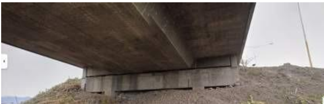
Imagen 10. Apoyo de tablero sobre la viga de bancada
