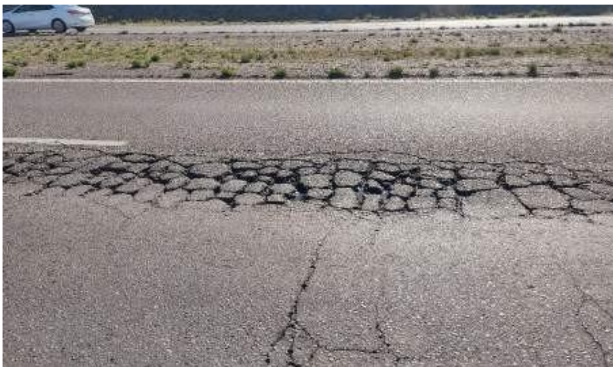
Imagen 3 Estado del pavimento existente en calzada ascendente. Fuente: Elaboración propia. Año: 2025.
