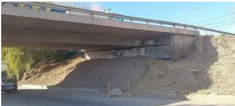
Imagen 4. Apoyo del tablero sobre la viga de bancada.
