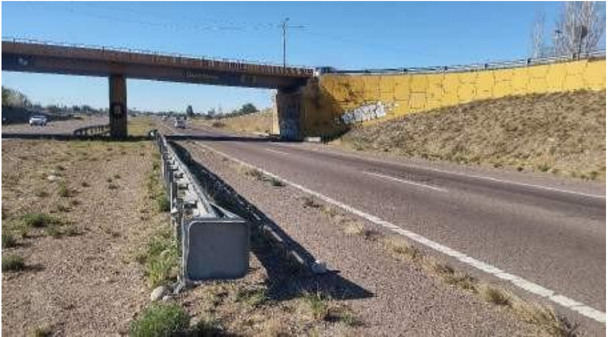
Imagen 5 Sistema de contención lateral sobre calzada ascendente. Fuente: Elaboración propia. Año: 2025.
